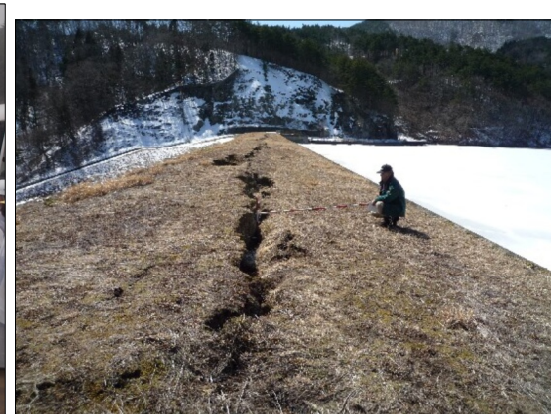
堤体に亀裂が生じている様子
