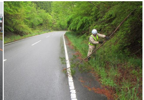
支障木撤去作業
