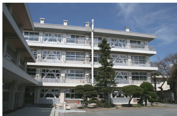
県有建築物の耐震化（施工後）
