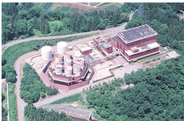
地熱発電（柳津西山地熱発電所）
