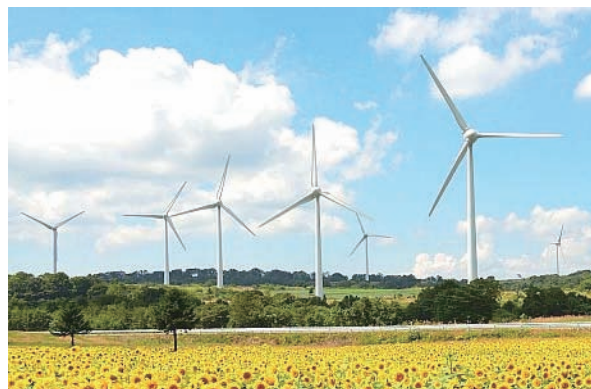
風力発電（郡山布引高原風力発電所）
