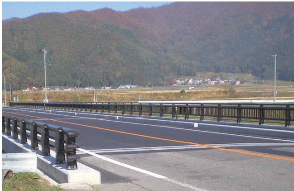
橋梁の長寿命化（施工後）
