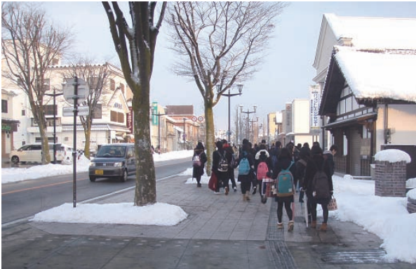
無電柱化された道路
