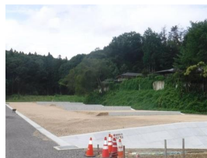
宅地の整地工事
