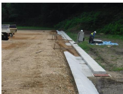
宅地の法面工事
