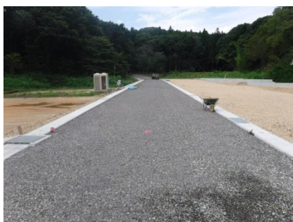
道路の路盤工事
