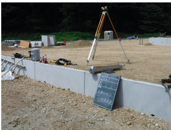
宅地の整地工事
