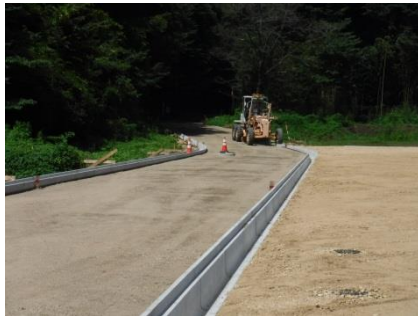
道路の路盤工事
