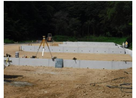
宅地の整地工事
