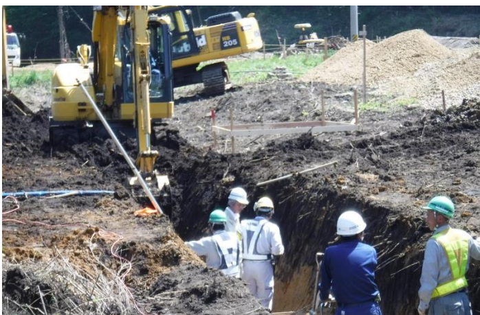
下水管布設工事
