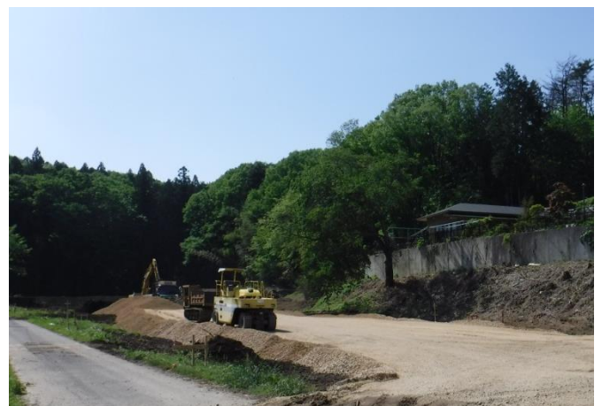
宅地造成工事
