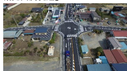
棚倉矢吹線(中島村) 平名塚工区
