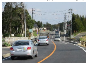
棚倉矢吹線(矢吹町) 三文橋
