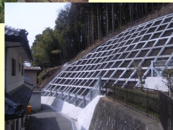
③ 箇所名：岩下 事業名：交付金事業 場所：白河市表郷八幡字岩下地内 工事説明：斜面崩壊等の危険性が懸念されるため、対策工事を実施します。また、人家だけでなく避難路である一般県道社田浅川線の保全も図ります。
