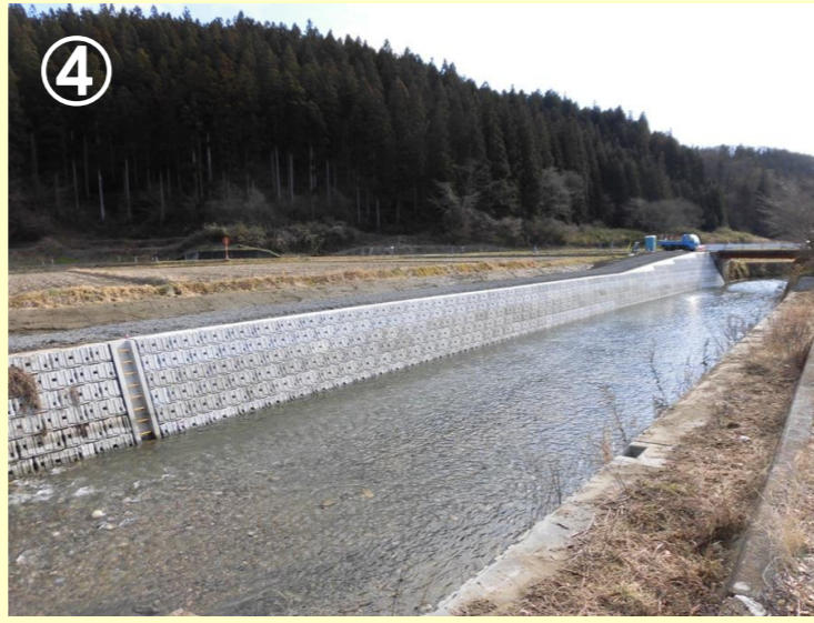
河川名：渡瀬川 事業名：河川海岸改良事業 場所：東白川郡鮫川村大字渡瀬地内 工事説明：村道や住宅の浸水被害を防止するため、河道拡幅や護岸工を整備しました。
