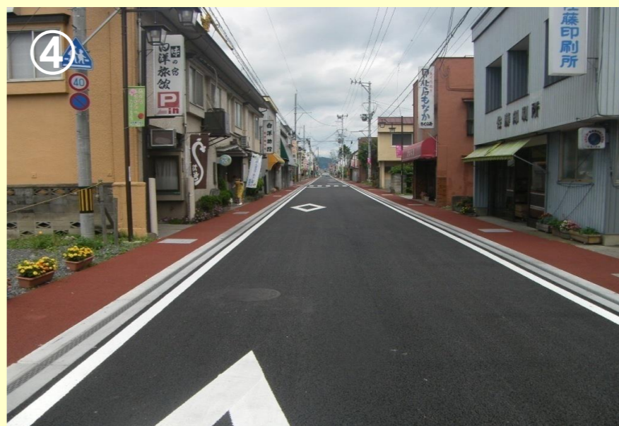
路線名：埴大津港線 事業名：元気ふくしま、地域づくり・交流促進事業 場所：東白川郡埴町大字埴地内 工事説明：埴町中心市街地活性化基本構想と本町地区の地域づくりを支援するため、埴大津港線の歩道部段差解消、歩道内の電柱移転、案内看板(サイン)の整備をしました。
