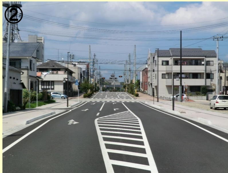
路線名：(都)白河駅白坂線 事業名：街路事業 場所：白河市大工町・向新蔵地内 工事説明：「白河の顔となるシンボルロード」を形成する道路として、安全安心な歩行空間を確保することで、地域の歴史を生かしたまちなか観光を確立しながら、中心市街地の活性化に寄与します。
