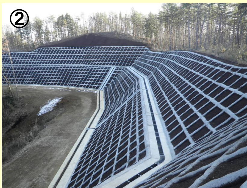
② 河川名：葉ノ木平 事業名：交付金事業 場所：白河市葉ノ木平地内 工事説明：平成23年3月11日の東北地方太平洋沖地震により、法面に亀裂等が確認され、地すべりの恐れがあるため、排土工及び法面工を施工し、地域住民の安全・安心を確保しました。
