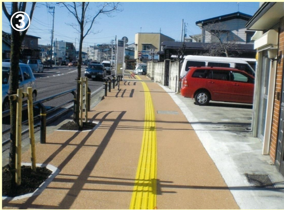
路線名：白河羽鳥線 事業名：やさしい道づくり推進事業 場所：白河市道場小路地内 工事説明：快適な歩行空間づくりを進めるため、歩道の段差解消および視覚障がい者用ブロックや透水性舗装の整備を進めています。
