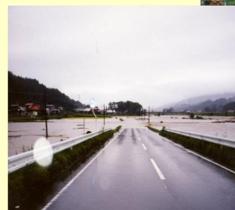
⑦ 河川名：久慈川 事業名：交付金事業 場所：東白川郡矢祭町大字関岡地内 工事説明：無堤区間における浸水被害を防止するため、築堤開削や護岸工の整備を進めていきます。
