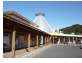
道の駅はなわ (堀倉町)
