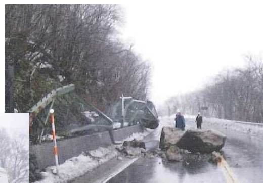
▲南会津町向山地区内（5 工区）での落石
