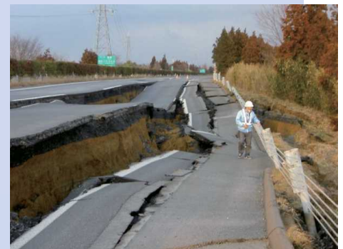
▲東日本大震災による道路崩壊（常磐道 水戸IC～那珂IC）
