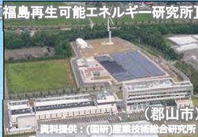
【福島再生可能エネルギー研究所】
