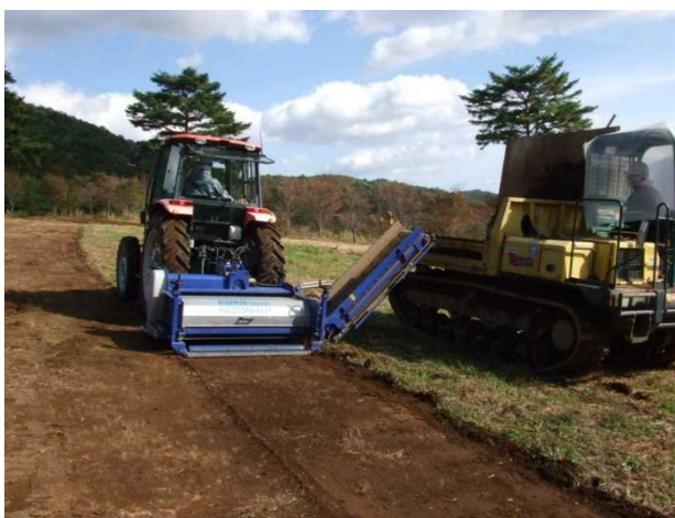
図4 トップソイラーによる表土除去
