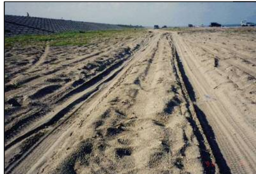
車両乗り入れによるわだち（山元町）
