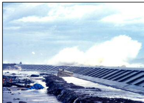
堤防に打ち寄せる高波浪（東松島市）
