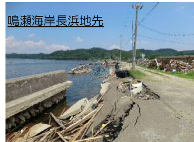
堤防の被災状況(東松島市)
