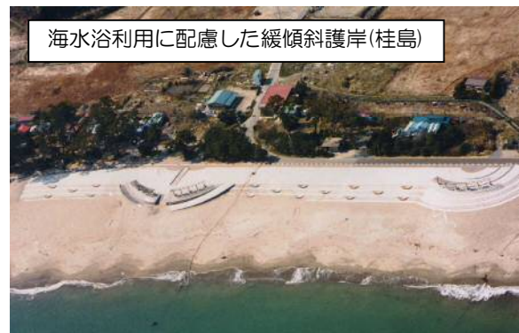
写真-4.1 海浜利用に配慮した整備例
