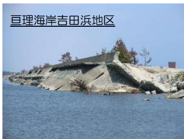
堤防の被災状況(亘理町)
