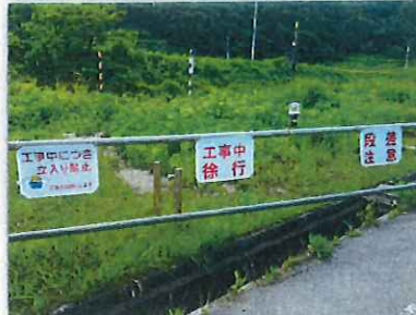
立入り禁止柵の設置
