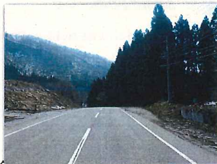
施工前の状況
