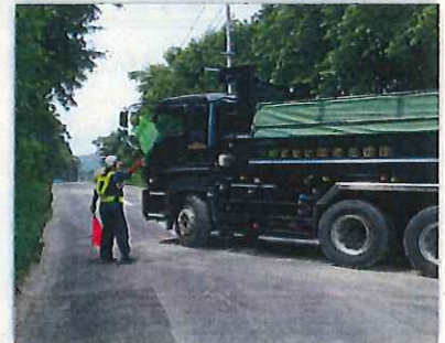
交通誘導員の誘導・配置
