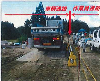
ダンプ通路と作業員通路の区別
