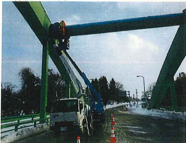
山都橋シート養生
