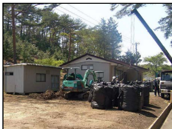
公共施設の除染状況(フレコン運搬)
