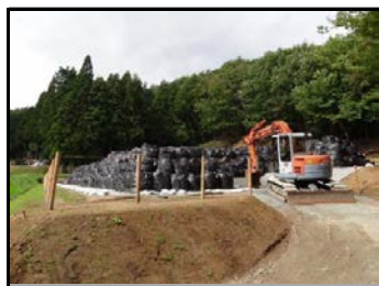
通気性防水シートキャッピング前
