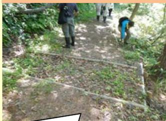
土砂の堆積が見られましたが、側溝として機能しており、路面は乾燥していました。
