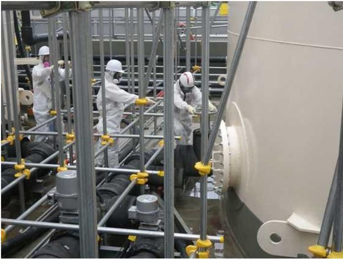
一時貯水タンクの出口弁を開操作している状況を確認した。（午前9時32分）
