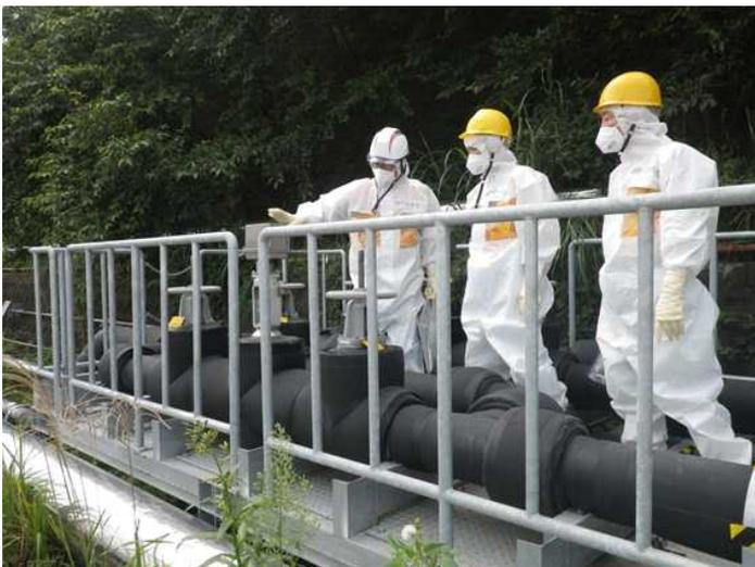
排水ライン流量調整弁の状況確認（70%開であることを確認）
