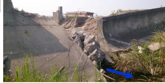
東日本大震災の津波では、現在の堤防を乗り越え堤防の裏側を洗掘し、引き波時に洗掘部(周囲より低い場所)に流れが集まり、堤防の裏側から崩壊したものと考えられる
