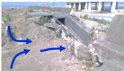
堤防越波による堤防裏側の洗掘
