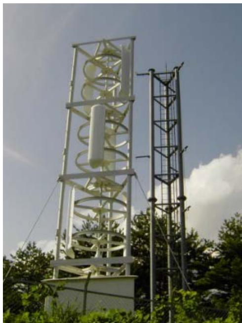
図 4.3-1 垂直軸型の小形風力発電システム
