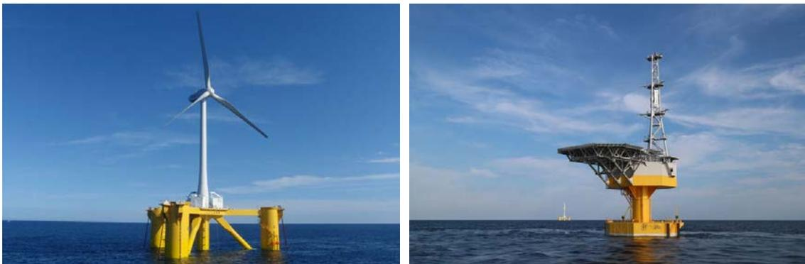
図 1.1-21 福島沖の浮体式洋上風力発電
