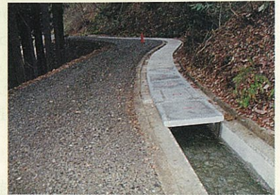
南会津町田部の水路改修工事
