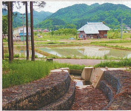
治山事業による復旧状況
