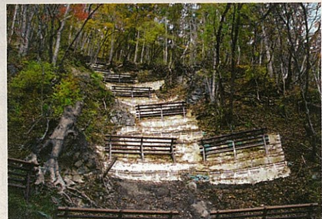
工事完了 県道脇斜面 なだれ防止柵設置 (平成18年11月)
