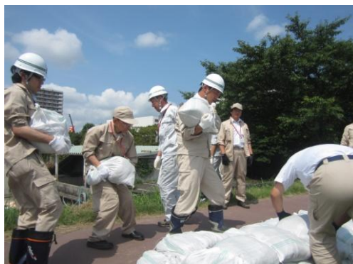
(土のう積み状況)
