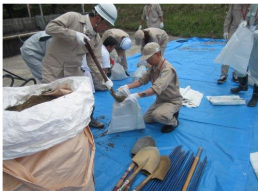
(土のう作り状況)
