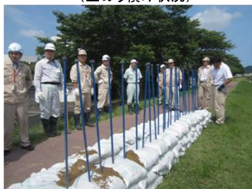
(積み土のう工完了状況)
