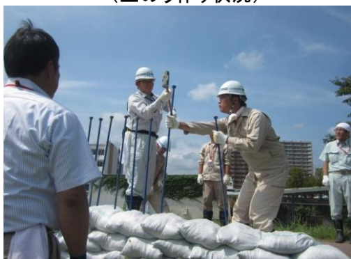
(鉄筋打設状況)
