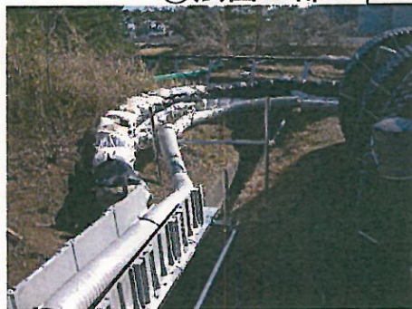
②法面上部
