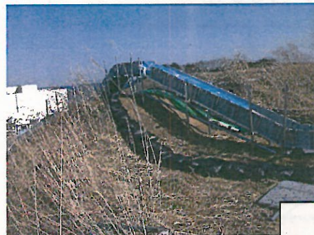
①法面上部
