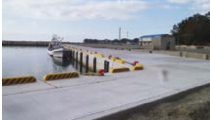
復旧状況(豊間漁港)
