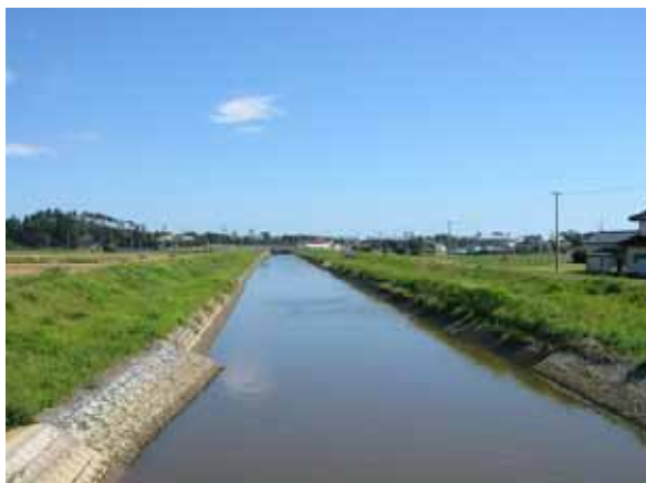
下流部の状況
