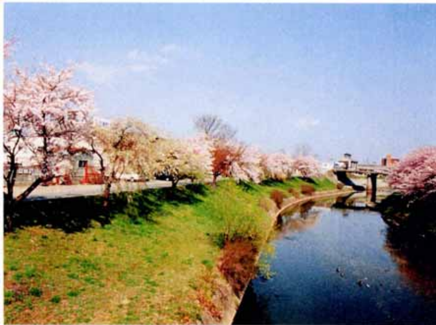
逢瀬川（幕内橋付近）
