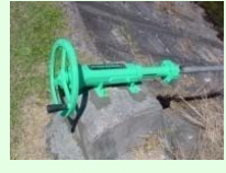
ゲート・バルブの更新
