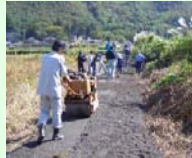
未舗装農道の舗装
