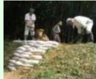
漏水箇所の補修
