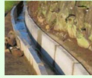
コンクリート水路の更新
