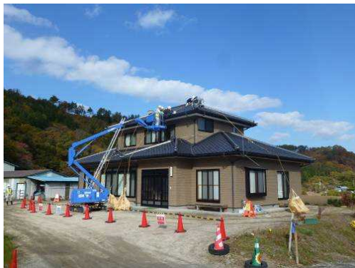
屋根・壁の拭き取り
