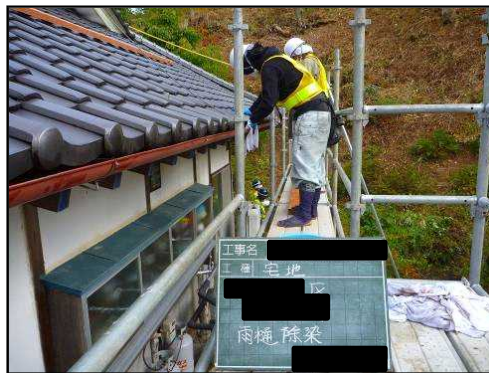
軒樋の拭き取り
