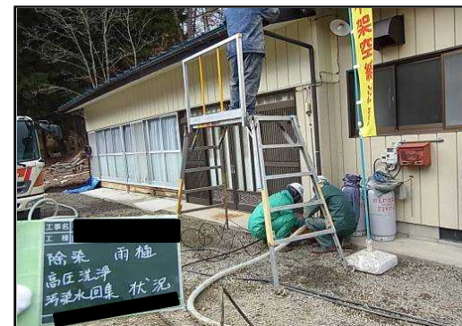
豎樋の高圧水洗浄
