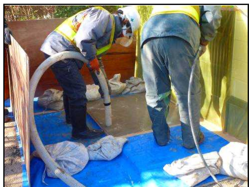
舗装面の高圧水洗浄
