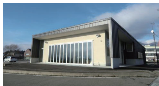
猪苗代水環境センター
