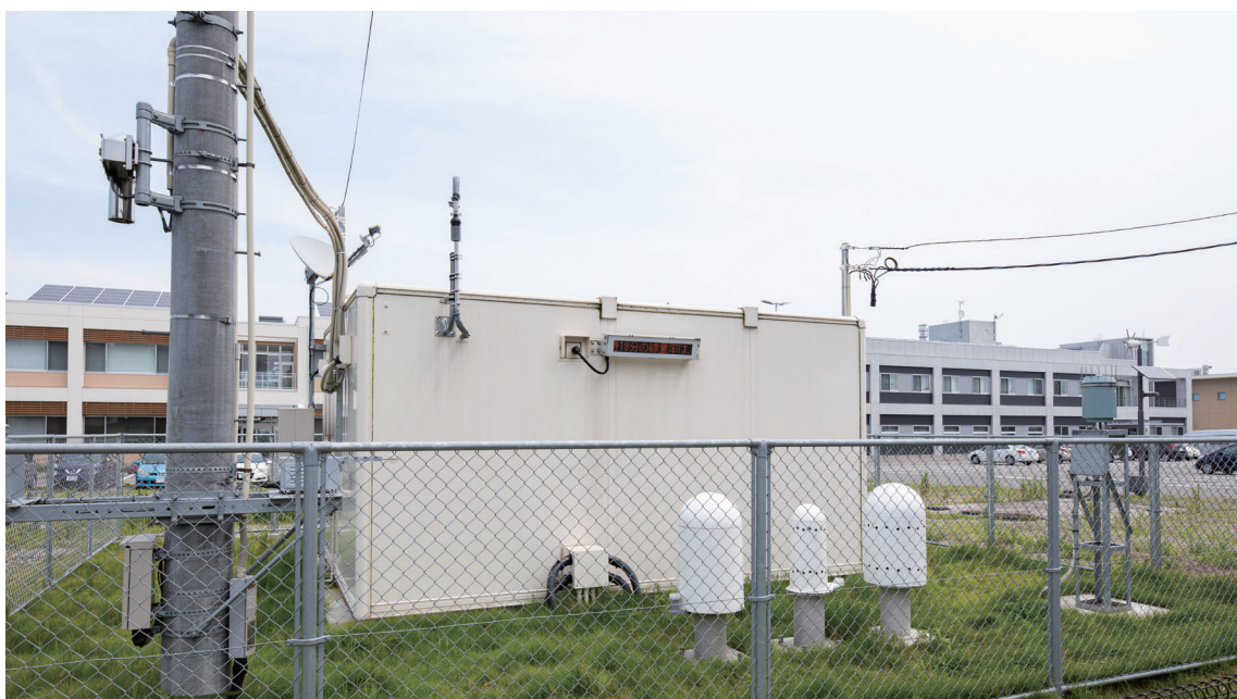
環境放射線センター敷地内に新設されたモニタリングポスト(萱浜局)
