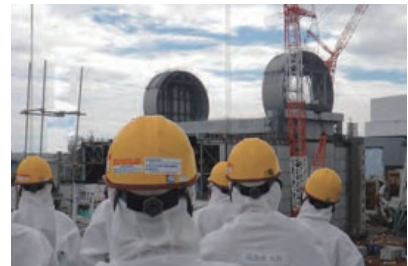
第4回廃炉安全監視協議会 (福島第一原発立入調査の様子)
