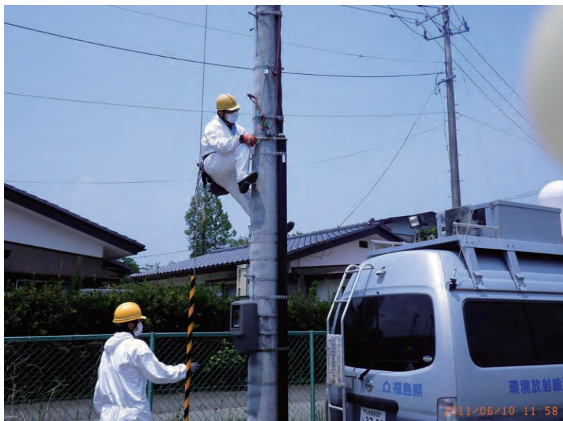
モニタリングポスト(大野局)の復旧作業の様子(2011年6月10日)
