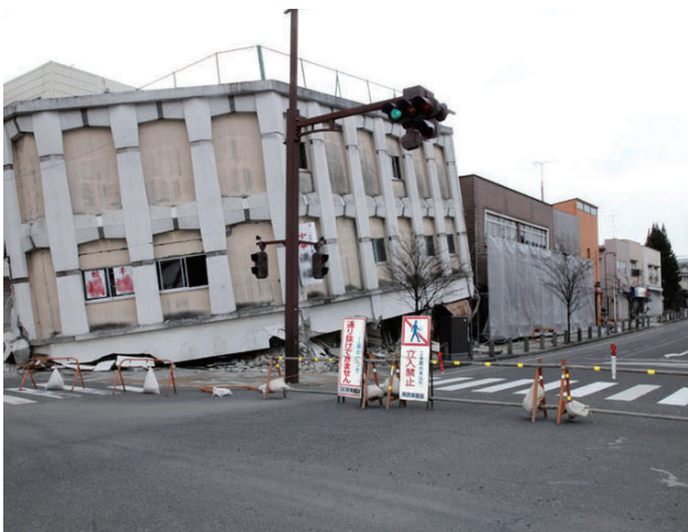
地震による建物倒壊(須賀川市)
