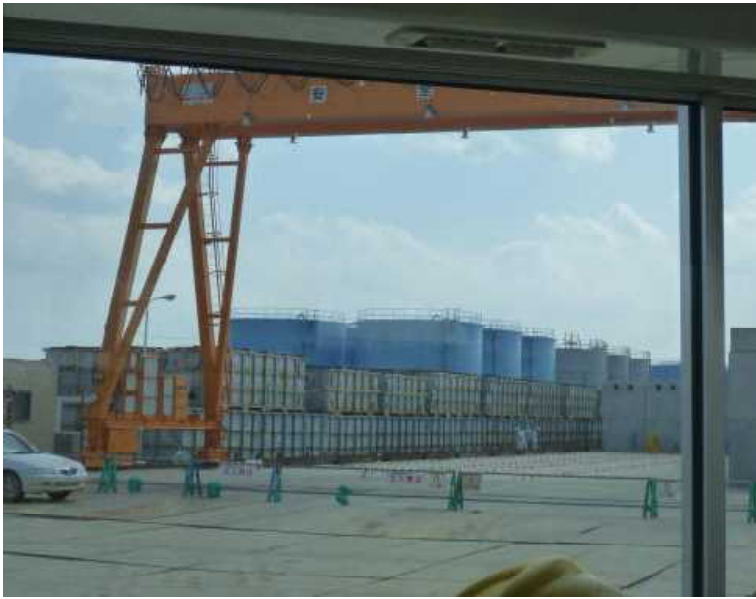
○使用済セシウム吸着塔 一時保管施設 (第一施設)
