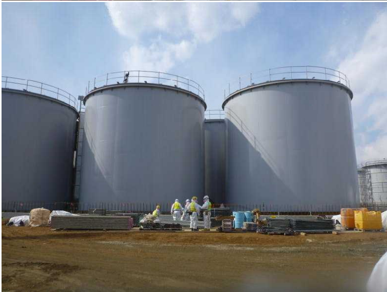
○ J1 タンクエリア 建設状況
