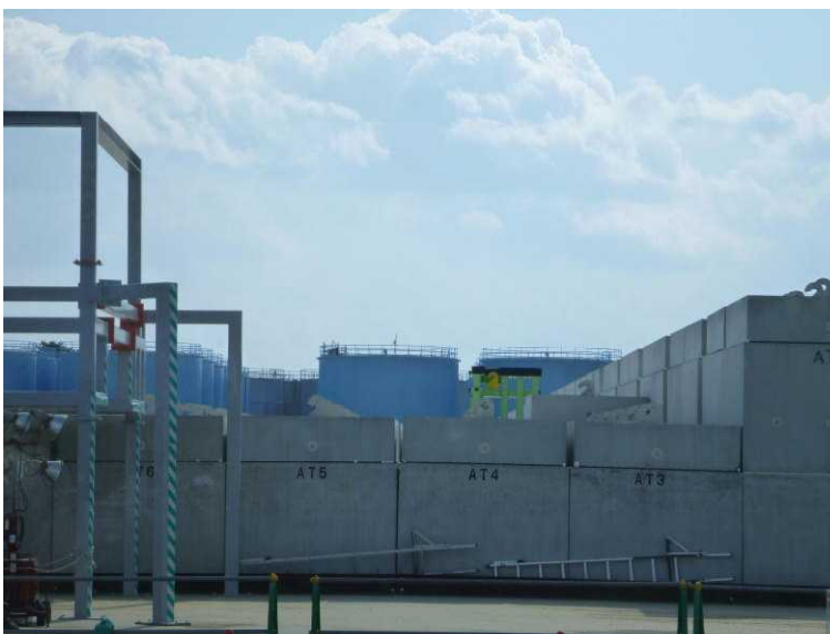
○使用済セシウム吸着塔 一時保管施設 (第二施設)
