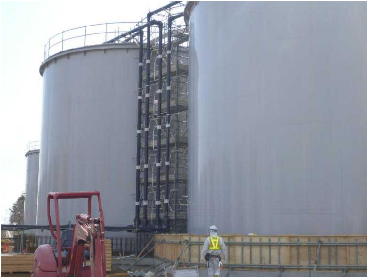
○ J1 タンクエリア 建設状況
