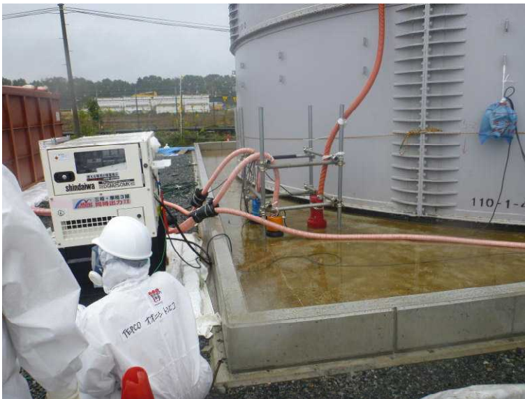
○現地確認 (Cエリアタンク)
