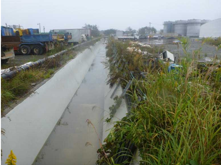
○排水路 コーティング後の様子 (C-1 より下流側)
