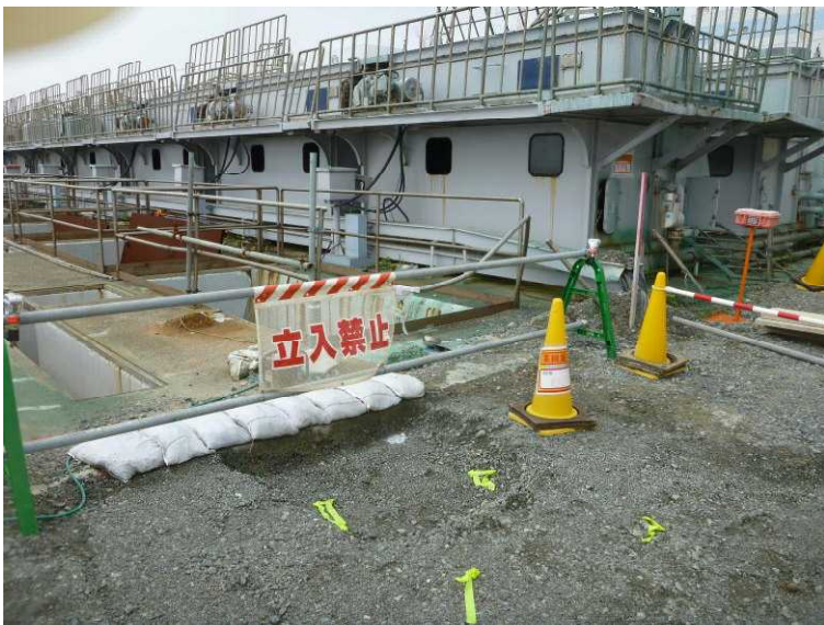
○高濃度汚染箇所止水状況 (2号機取水電源トレンチ)
