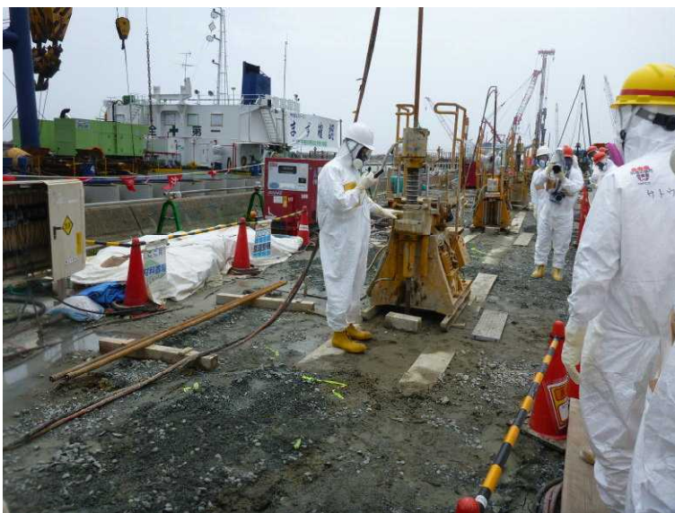
○地盤改良工事用ボーリン グ装置 (1-2号機取水 口間)
