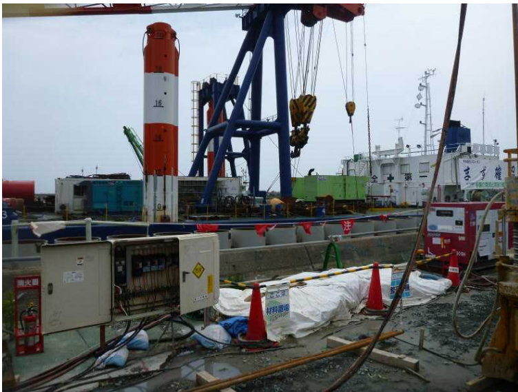
○海側遮水壁建設中 (1-2号機取水口間)
