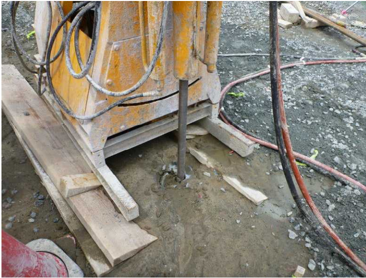
○ボーリング装置拡大 (1-2号機取水口間)
