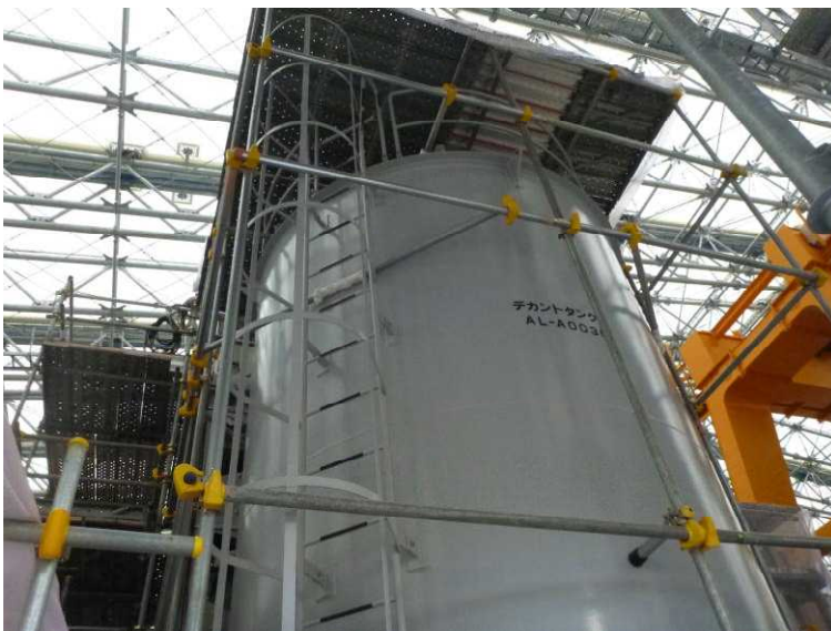
○デカントタンク (多核種除去施設(ALPS)) バッチ処理タンクからの 上澄み液が入る
