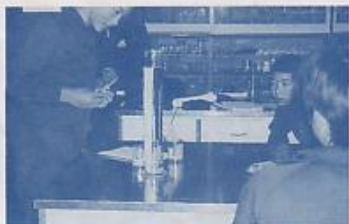
サラダ油中の水滴の落下運動を調べる...
