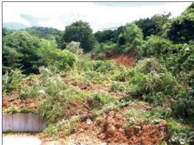
福島市大波地区の土砂崩れの様子
