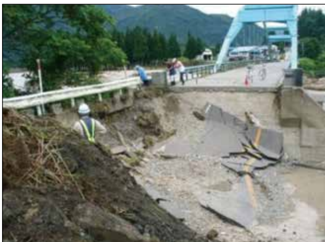
国道252号 蒲生橋(只見町蒲生地内)
