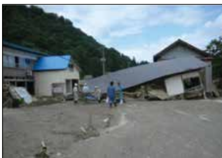
国道252号(只見町八木沢地内)
