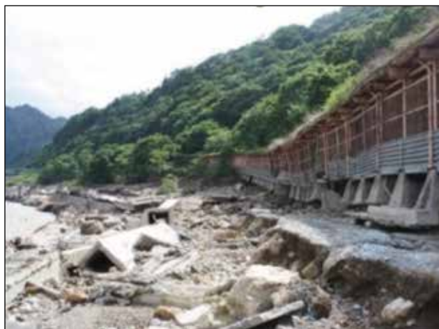
国道252号 滝スノーシェッド(金山町滝地内)
