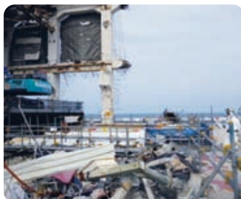
②平成24年6月14日撮影(建屋上部)
