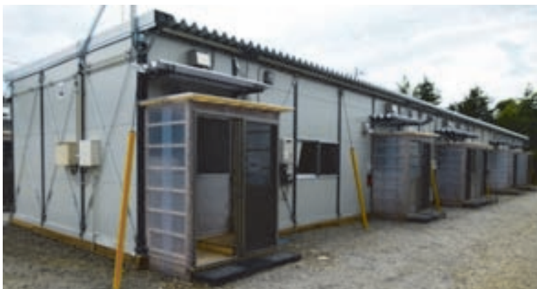
仮設住宅の写真
