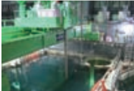
燃料取り出し作業中 (撮影日:平成25年11月18日)
