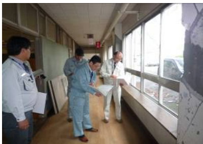
(災害査定現地調査の様子)
