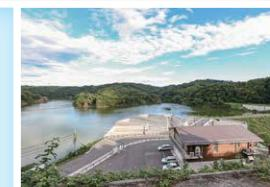
昭和50年(1975)に建設されたかんがい専用ダムで、新たに洪水調節を行うために改築工事を経て、令和6年(2024年)に完成。ラビリンス型とよばれる洪水吐き(洪水を安全に下流に流す施設)の形に注目！
