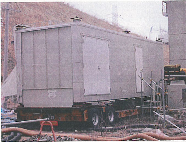
コンテナ側面 仮設3/4号M/C入口
