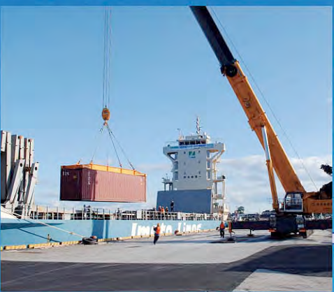
相馬港応急工事完了
