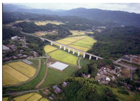
同左 施工後（H23撮影）
