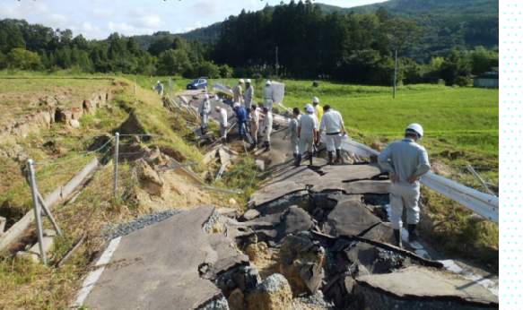
原形をとどめない断層上の 高谷地地区の農道 (いわき市)
