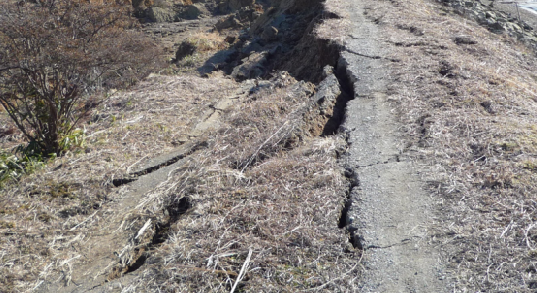
決壊した 青田新池の堤体 (本宮市)
