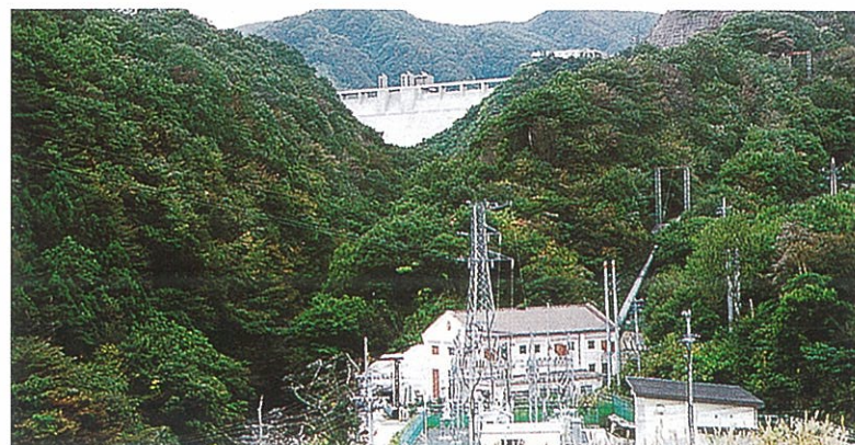
▲小玉ダムと東北電力小玉川第一発電所
