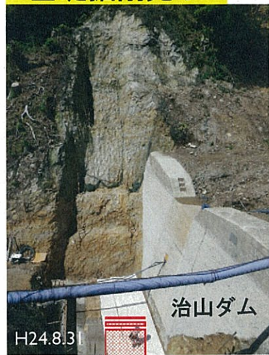
基礎掘削完了
