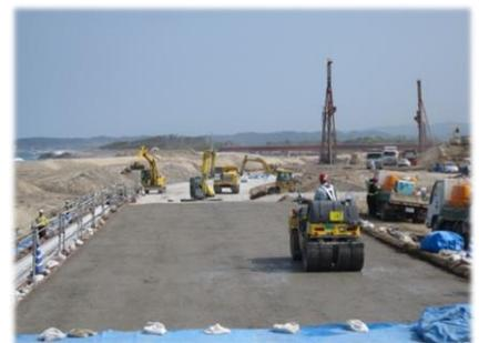
その後、振動ローラーによって転圧され、締め固められます。このようにして、堤防は階段状に建設されていきます。
