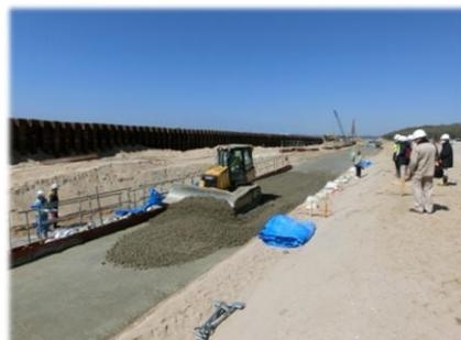
運搬されてきた CSG 材は、ブルドーザによって平らに敷均されます。
