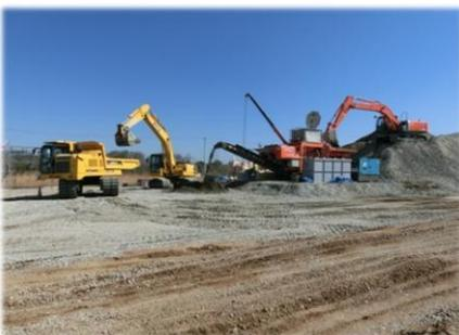
搬入されたガラは、破碎機で細かく砕かれ、セメント・水と混ざりあって、堤防の材料 (CSG) になります。
