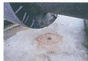
H5-IV-No.5タンク 出口弁フランジ(8/31)
