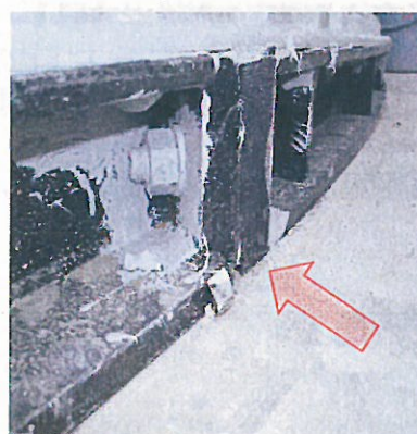
タンク底板フランジ接合部写真
