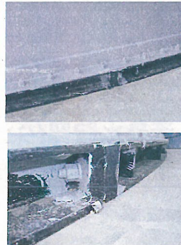
タンク底板フランジ接合部写真
