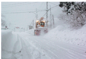
ロータリー除雪車による拡幅作業
