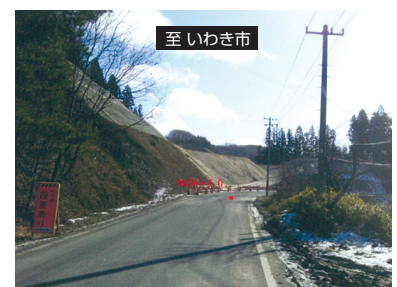
▲国道289号（青生野拡幅）の施工状況
