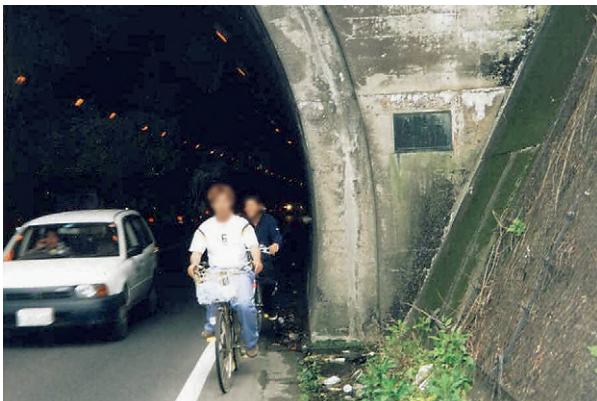
主要地方道 いわき上三坂小野 泉トンネル
