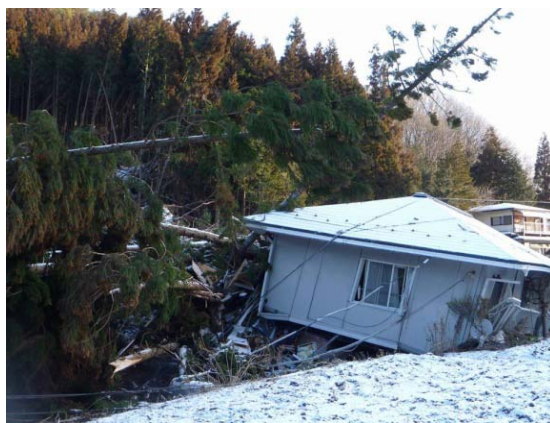
写真 2-1 山腹崩壊に伴う住宅被害 （白河市大信隈戸地内） （平成23年3月14日撮影）
