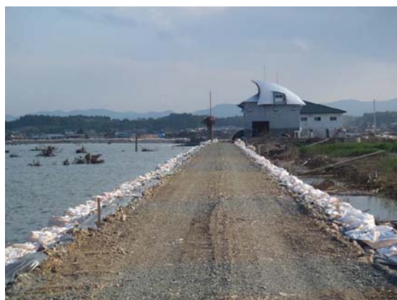
写真 2-42 仮締切後 (平成 23 年 7 月 14 日撮影)
