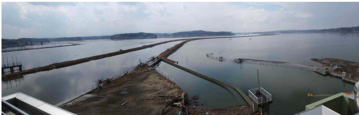
写真 2-51 八沢排水機場受益地（被災直後の状況）（南相馬市） （平成 23 年 4 月 3 日撮影）
