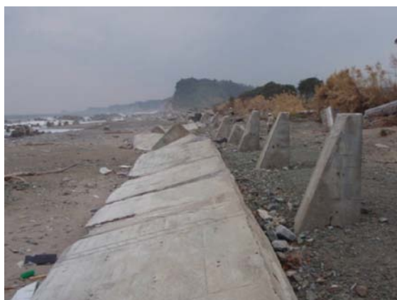
写真 2-39 仮締切工事実施前 (平成 23 年 5 月 17 日撮影)
