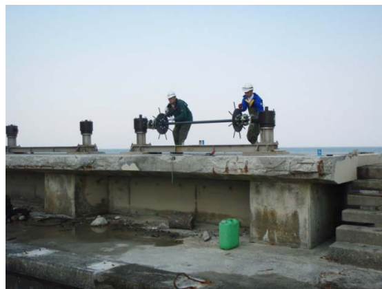
写真 2-34 手動でのゲート開閉作業 (相馬市・南相馬市 八沢地区) (平成23年4月14日撮影)
