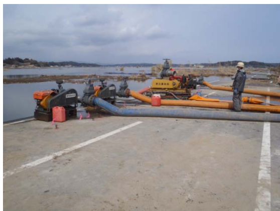
写真 2-33 ポンプによる排水状況 (相馬市・南相馬市 八沢地区) (平成23年3月25日撮影)
