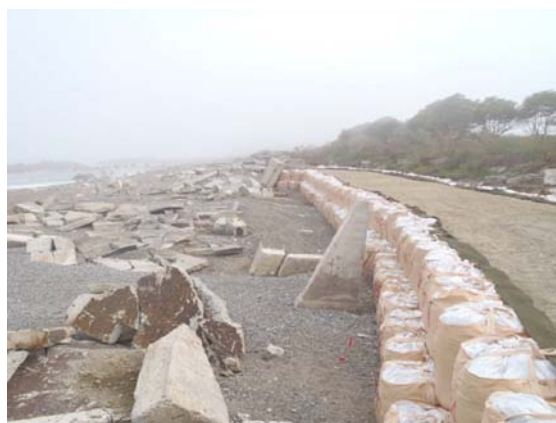
写真 2-40 仮締切工事実施後 (平成 23 年 8 月 5 日撮影)
