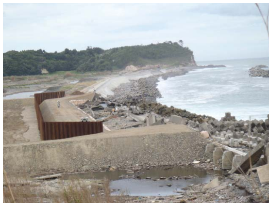
写真 2-38 仮締切工事实施後 (平成 23 年 7 月 19 日撮影)
