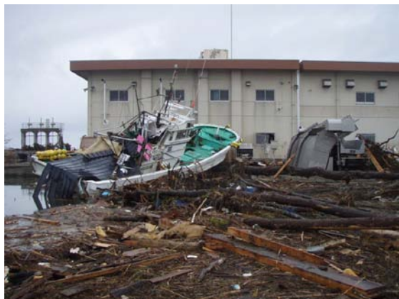
写真 2-45 被災直後 (平成 23 年 3 月 23 日撮影)
