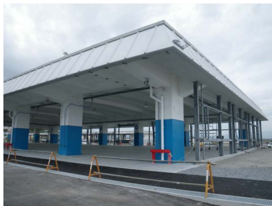
写真 2-54 同左応急復旧中 （平成 23 年 7 月撮影）
