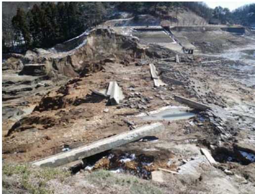
写真 2-9 地震により決壊したため池 (須賀川市 藤沼湖) (平成 23 年 3 月 12 日撮影)
