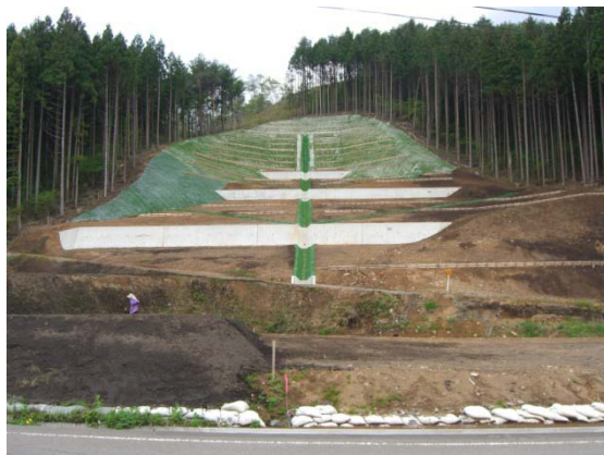
写真 2-75 同左復旧後 （平成 24 年 3 月 29 日撮影）
