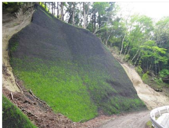
写真 2-73 同左復旧後 （平成 24 年 5 月 25 日撮影）
