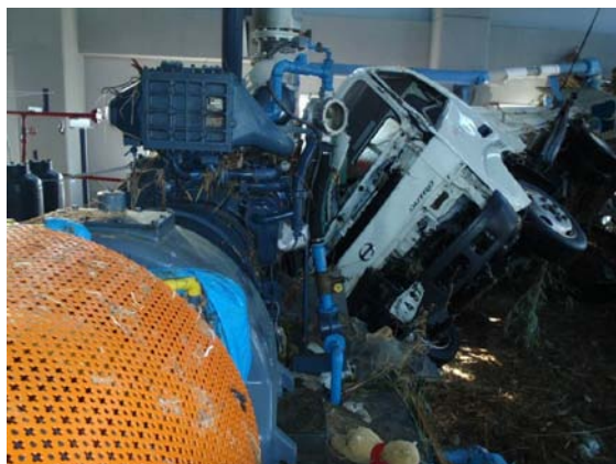
写真 2-47 被災直後 (平成 23 年 3 月 29 日撮影)
