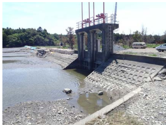
写真 2-44 仮締切状況 (平成 23 年 6 月 15 日撮影)
