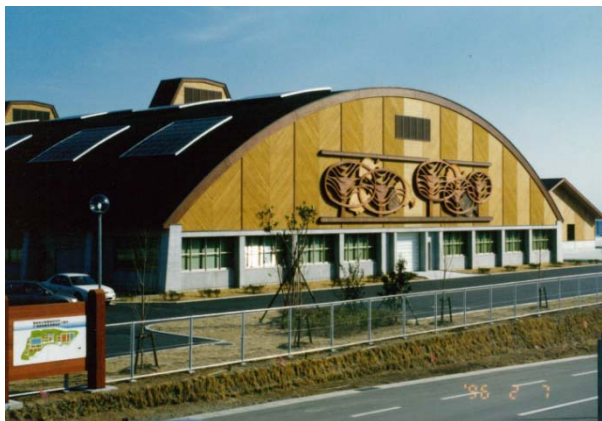
写真 2-31 ヒラメ栽培漁業振興施設被災前 (大熊町) (平成 8 年 2 月 7 日撮影)
