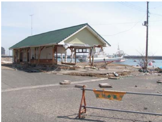
写真 2-29 いわき市漁協江名共同作業場 (平成 23 年 3 月 14 日撮影)
