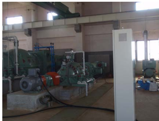
写真 2-50 仮復旧後 (平成 23 年 8 月 12 日撮影)
