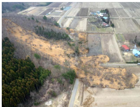
写真 2-24 山腹崩壊状況（天栄村） （平成 23 年 3 月 30 日撮影）
