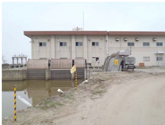
写真 2-46 応急工事実施後 (平成 23 年 6 月 15 日撮影)
