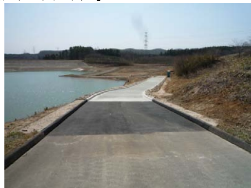
写真 2-64 同左復旧後 (平成 24 年 3 月下旬撮影)
