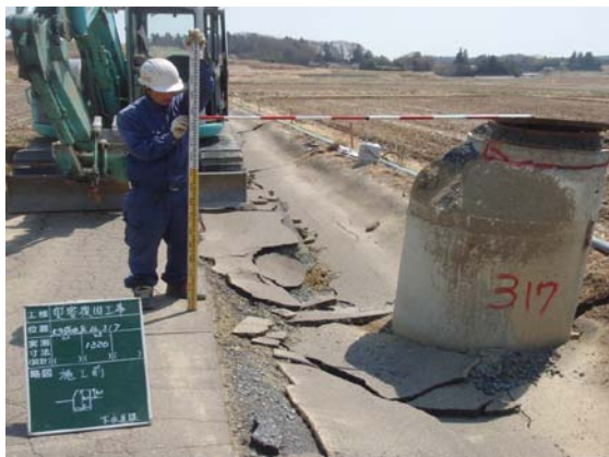
写真 2-35 応急工事实施前 (平成 23 年 3 月下旬撮影)
