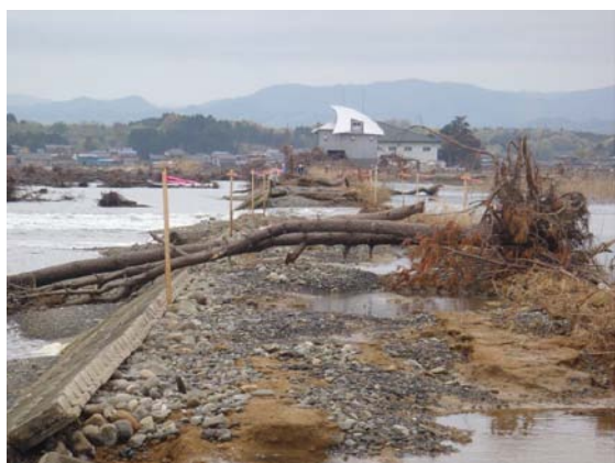
写真 2-41 被災状況 (平成 23 年 5 月 6 日撮影)
