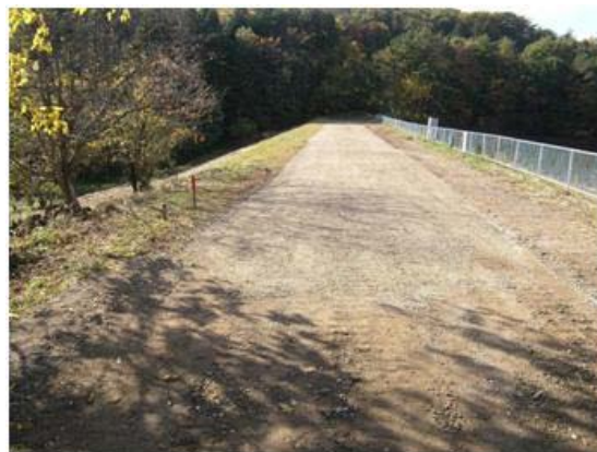
写真 2-71 同左復旧後 (平成 23 年 11 月 8 日撮影)
