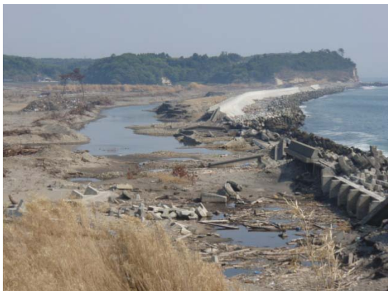
写真 2-37 仮締切工事实施前 (平成 23 年 4 月 22 日撮影)
