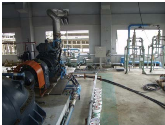
写真 2-48 仮復旧後 (平成 23 年 7 月 7 日撮影)
