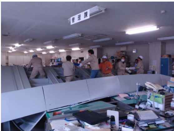
写真 1-1 いわき合同庁舎被災状況 (平成 23 年 3 月 13 日撮影)
