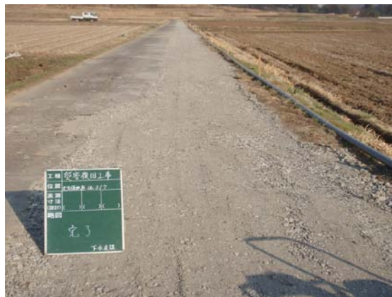
写真 2-36 応急工事实施後 (平成 23 年 4 月上旬撮影)
