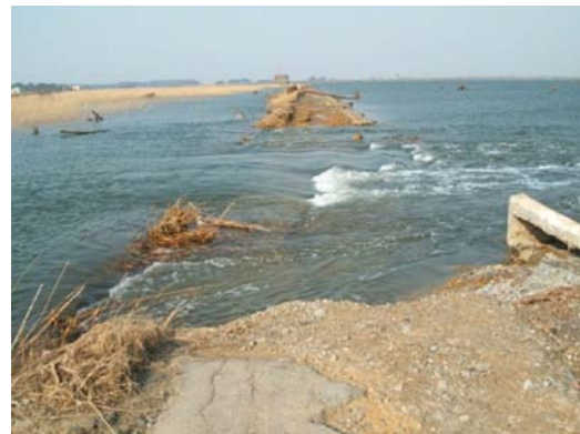
写真 2-14 松川浦湖岸堤防被災状況 (相馬市) (平成 23 年 4 月 13 日撮影)
