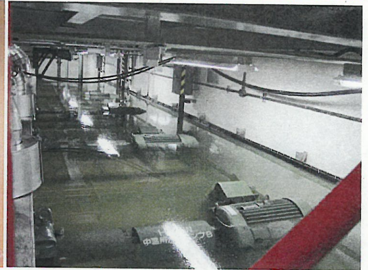
3号機活性炭ホールドアップ建屋*10
