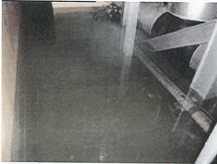
1号機原子炉建屋地下2階
