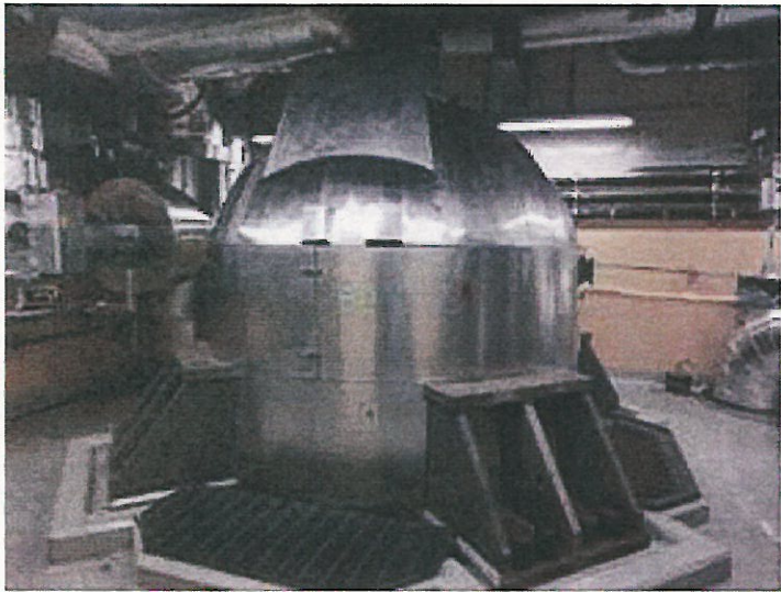
残留熱除去系 (RHR) 熱交換器
