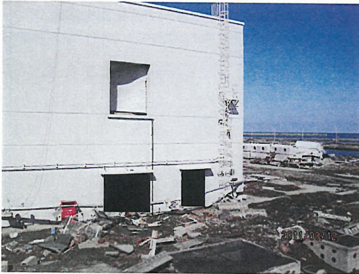
1号機海水熱交換器建屋
