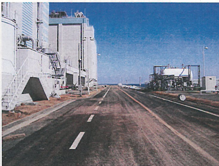
1号機原子炉建屋南側
