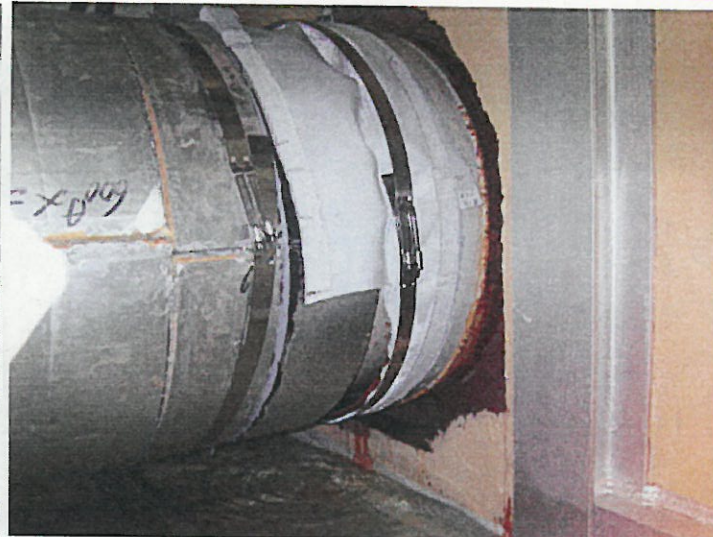
1号機原子炉建屋配管貫通部
